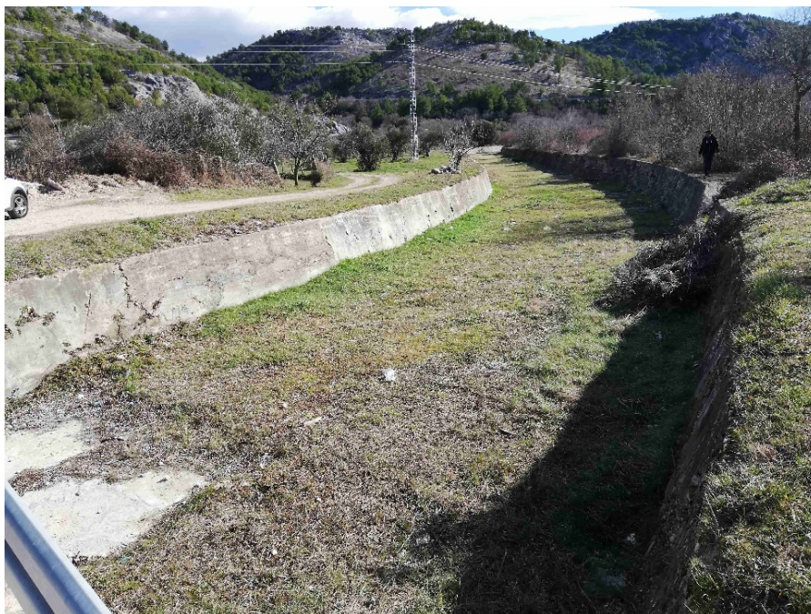
Slika 2.2.-3 Vodotoka Rivina jaruga nizvodno od mosta (čvorište starog i novog korita)
