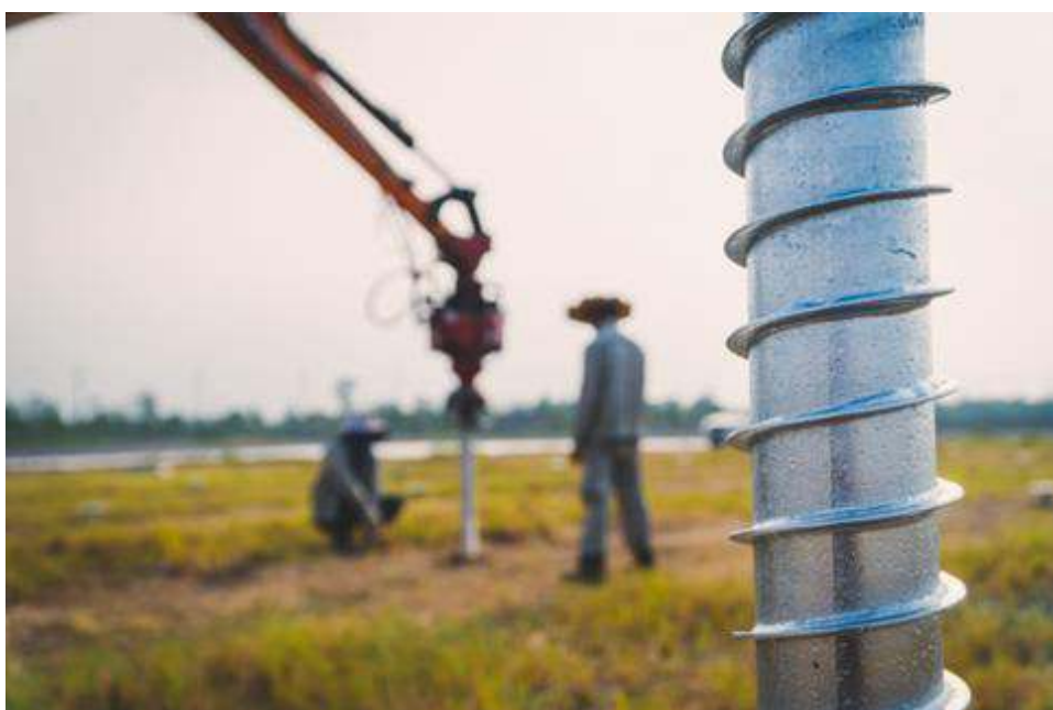
Slika 21. Postavljanje sidrenih vijaka
