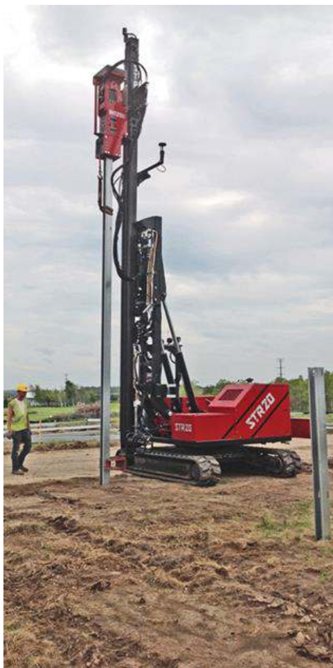
Slika 20. Postavljanje čeličnih greda u zemlju
