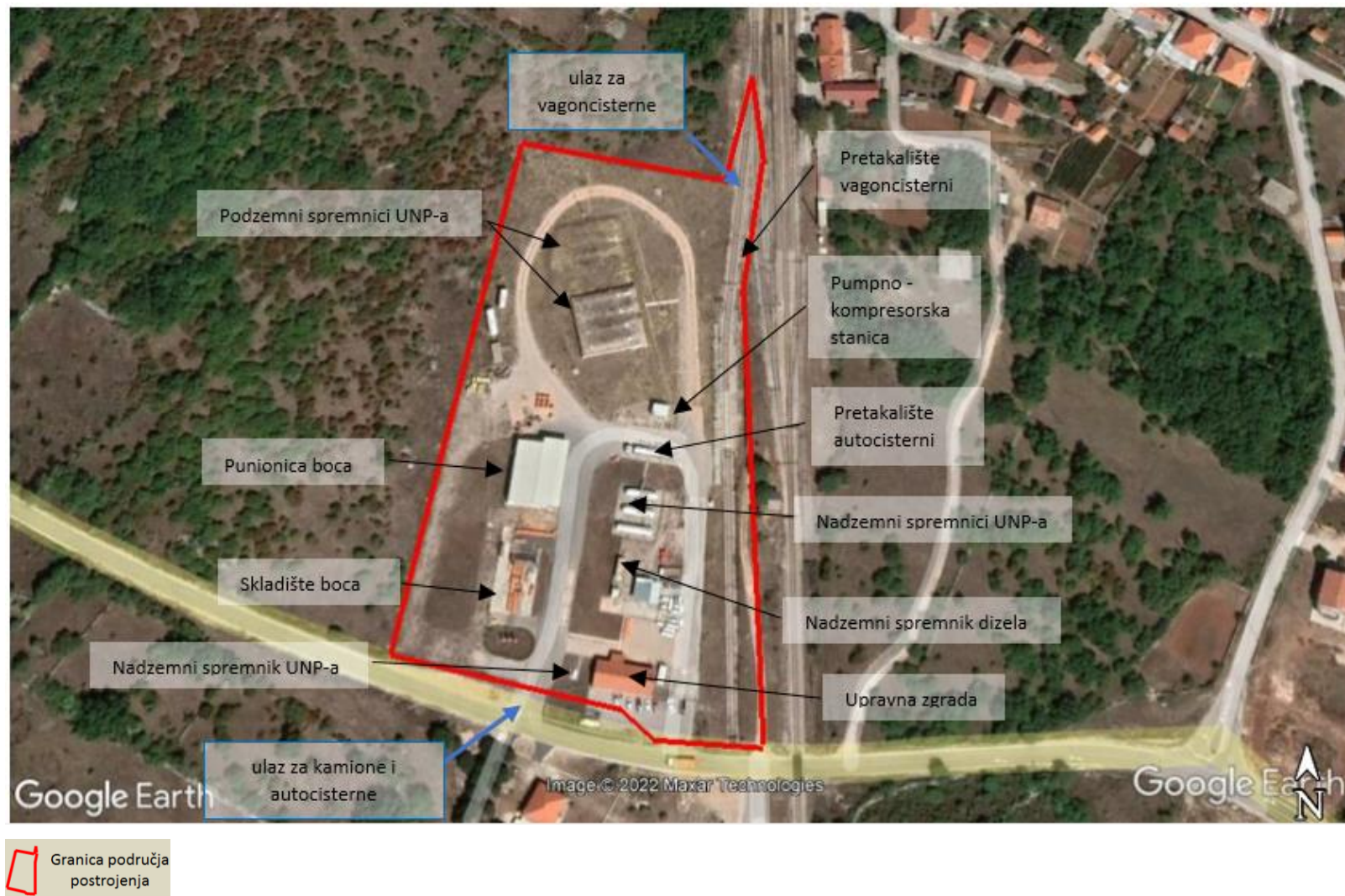
Slika 2. Dijelovi postrojenja Skladište i punionica plina Unešić
