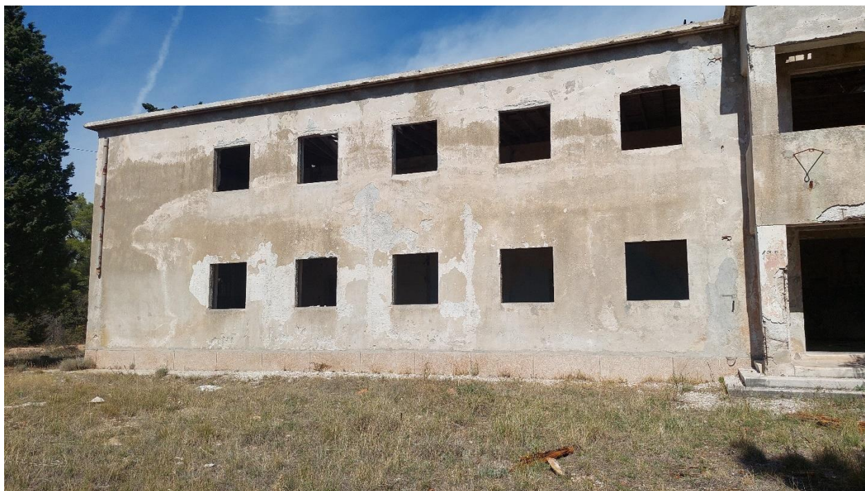
Slika 1.6 Zgrada stare škole koja se ruši
