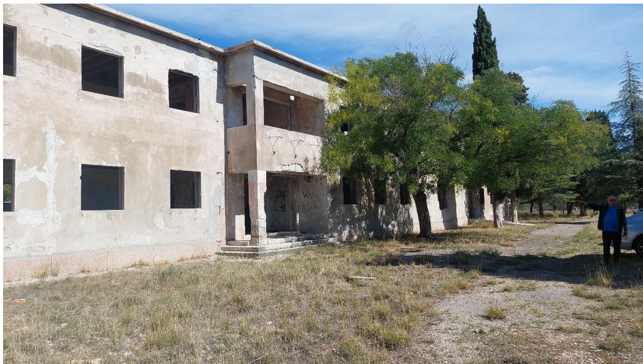
Slika 1.5 Zgrada stare škole koja se ruši
