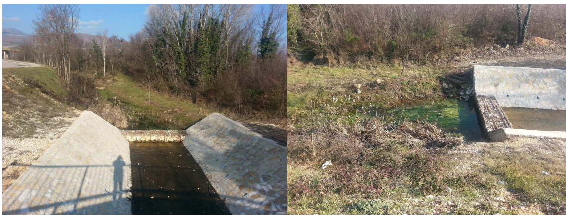
Slika 2.3-2 Prag od gabiona (lijevo) i pogled na prag s desne obale bujice Trzibalićevac (desno).
