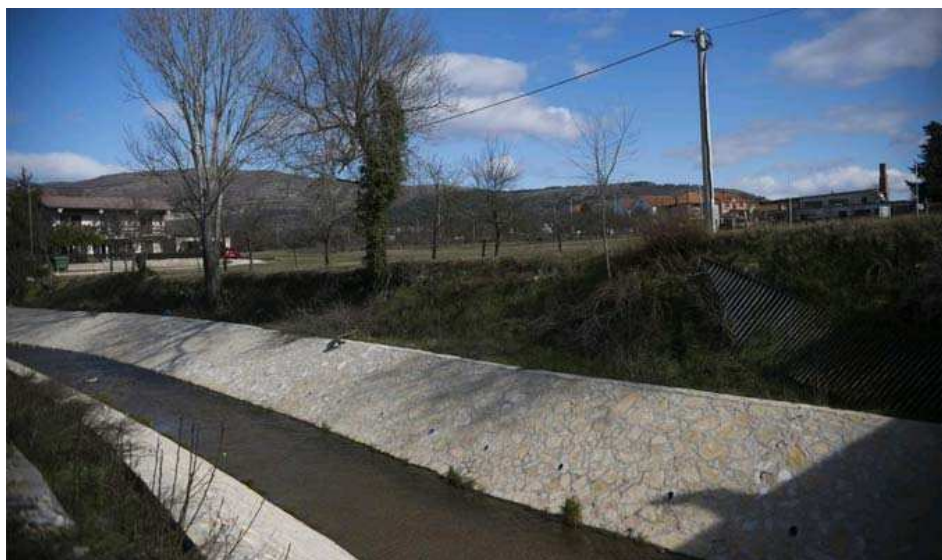
Slika 2.3-1 Prikaz dijela bujice Trzibalićevac reguliran armirano-betonskim koritom.
