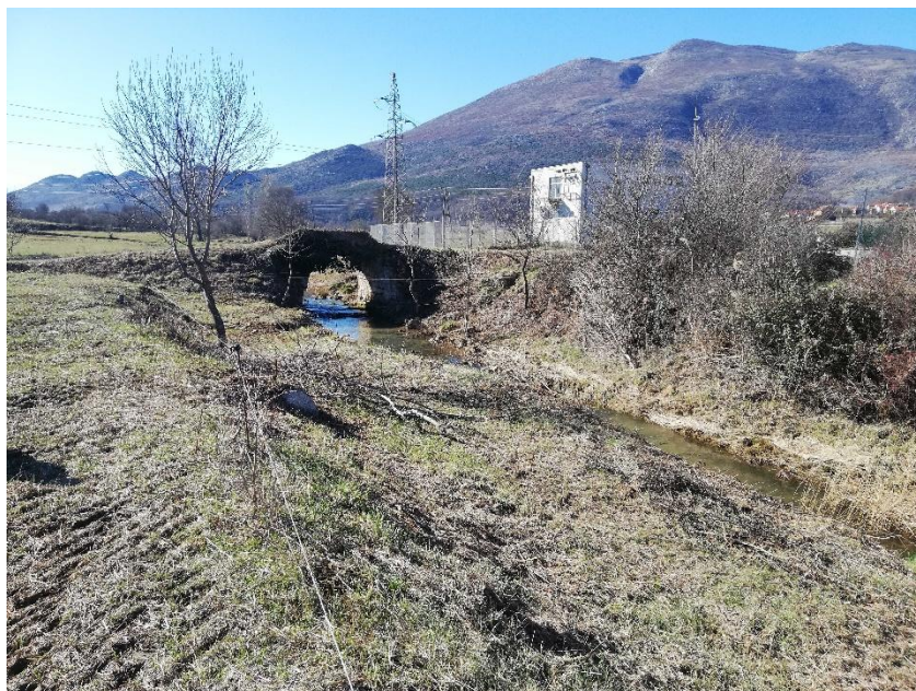
Slika 2.2.1 Uzvodni dio predmetne dionice (P-22, most, prijelaz preko korita)
