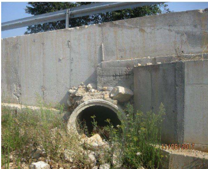
Slika 2.2 Propust kroz trup lokalne ceste (Izvor: Idejni projekt)
