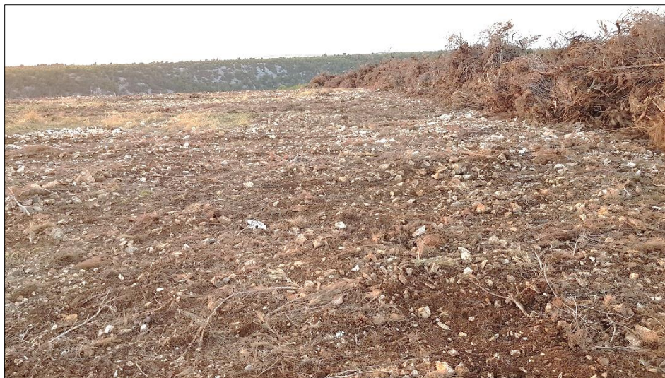
Fotografija 2: Područje zahvata nakon skidanja vegetacije bageriranjem (sjeverni dio zahvata)
